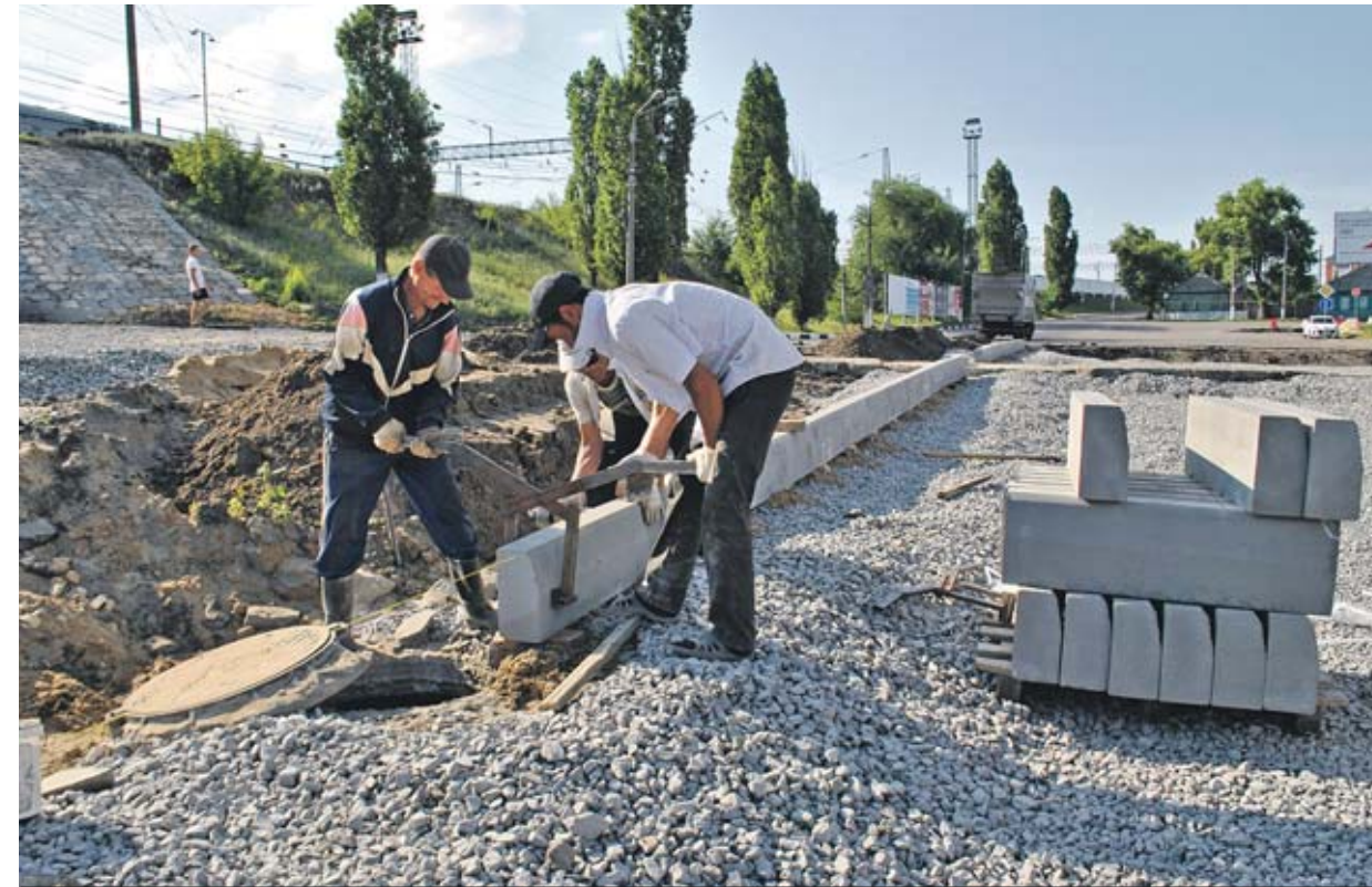
Идут работы по направлению к улице Луначарского
